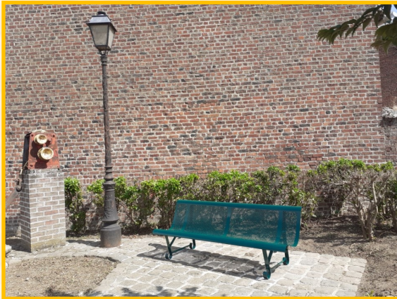
Pose d'un banc métallique et d'une poubelle au square rue d'Héronville
